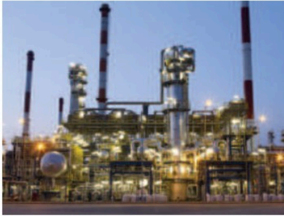
محطة توليد الكهرباء في الجبيل
