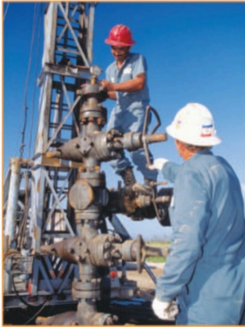
يعملُ حفَّارو الآبارِ على حفرِ بئرِ نفطٍ.
